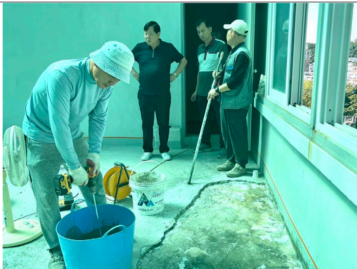
女生宿舍曬衣場防水維修工程 20230908
