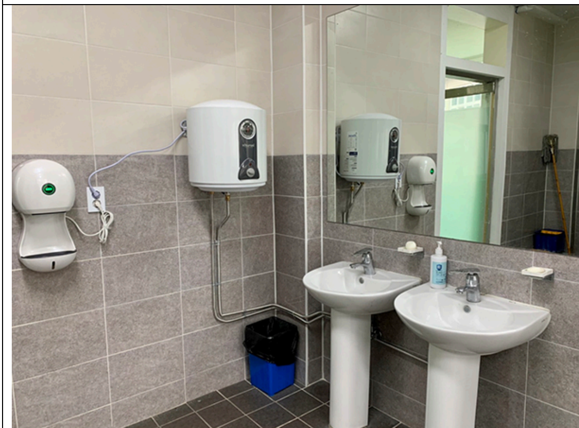
A, B 棟大樓內廁所按裝熱水器 2022. 03. 16
