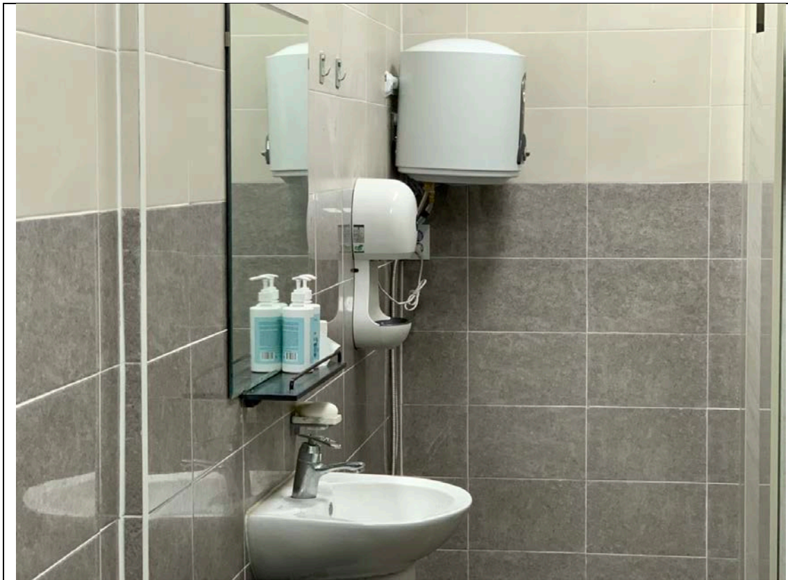
A, B 棟大樓內廁所按裝熱水器 2022. 03. 16
